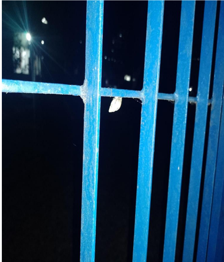
Figura: 27: em portão da casa dos estudantes da UFRPE
